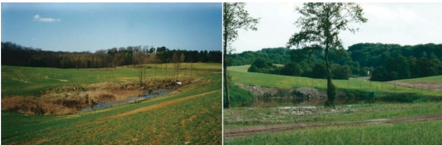
Rys. 3. Zbiornik nr I po wycięciu drzew przed odbudową (po lewej) i po odbudowie (po prawej)
