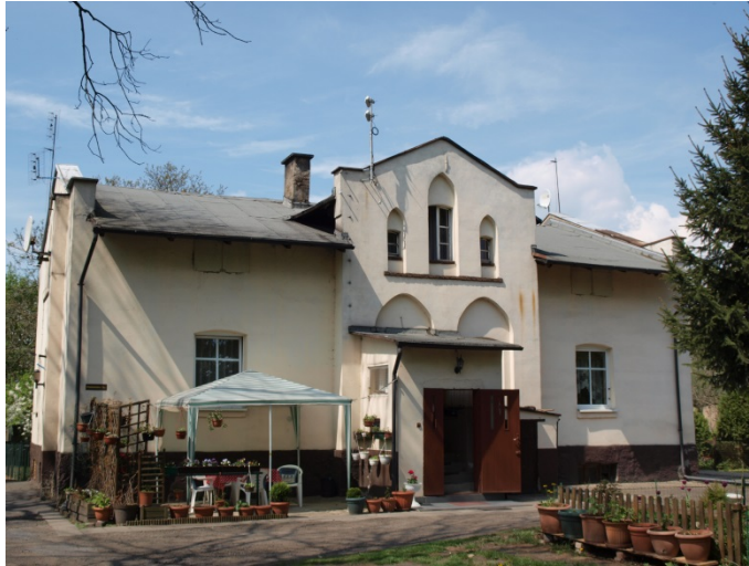
Rys. 9. Oficyna w 2011 roku (fot. J. Bykowska) Fig. 9. Outbuilding in 2011 (photo by J. Bykowska)
