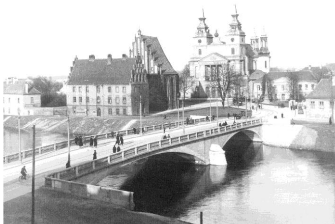
Rys. 2. Najbardziej „stabilna” panorama „sakralnego” Ostrowa Tumskiego z katedrą, kościołem NMP, Psalterią i kanoniami, pięknie dopełniona w okresie międzywojennym betonowym mostem według projektu Łucjana Ballenstedta (KAROLCZAK 2001)
