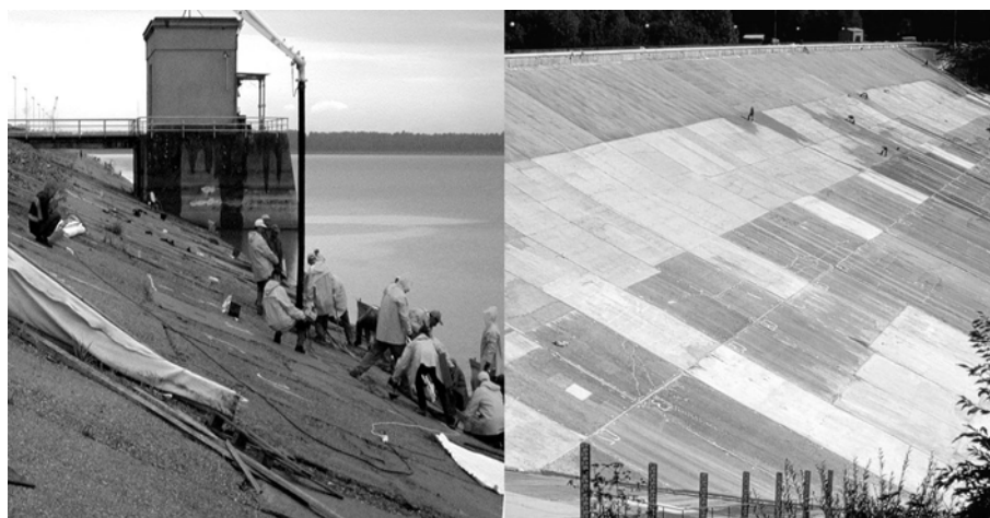
Rys. 7. Wykonywanie naprawy betonu (z lewej) i zabezpieczenia powierzchni (z prawej) na skarpie odwodnej zapory
